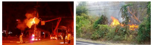
รูปที่ 4 ความเสียหายของเคเบิลใยนำแสงจากไฟไหม้
